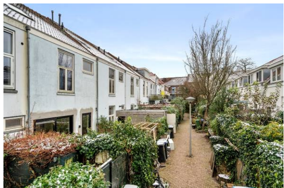
Hofje aan achterzijde
